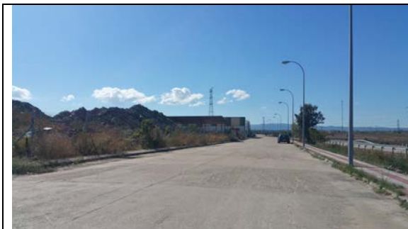
Vial existente en polígono industrial.
