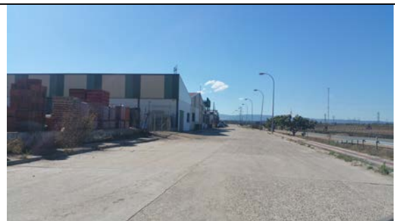
Vial existente en polígono industrial.
