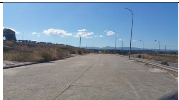
Vial existente en polígono industrial.
