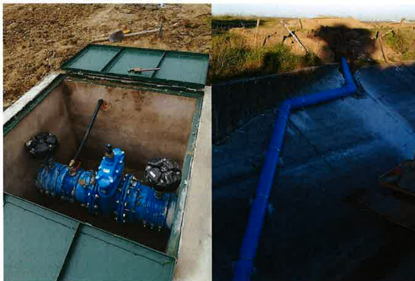
Fig. 8-Arqueta prefabricada y conexión tubería enterrada.
