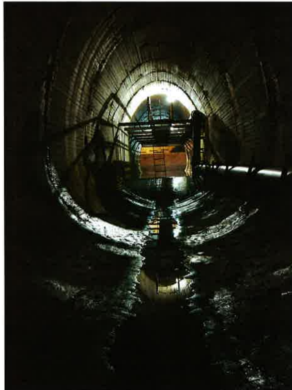
Fig. 4-Fotografía de inicio de tubería antigua de fibrocemento en túnel, donde puede verse al fondo a la derecha los dos codos de 90° que existían en su momento.
