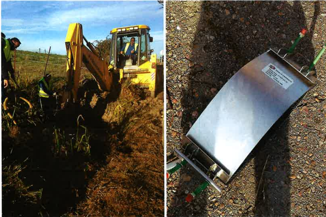
Fig. 3-Fotografía de reparación fuga en tubería enterrada abastecimiento actual y abrazadera de gran tolerancia utilizada en dichas reparaciones
