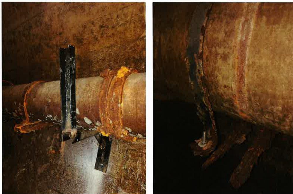
Fig. 9-Detalles anclajes y soportes metálicos a desmontar
