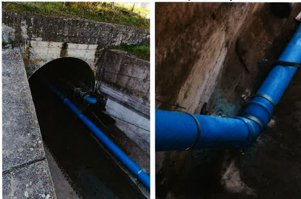
Fig. 6-Nueva tubería PVC-O en inicio y fin de túnel respectivamente.
