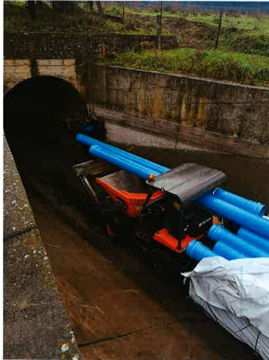
Fig. 11-Dumper con PVC-O en obra 2019
